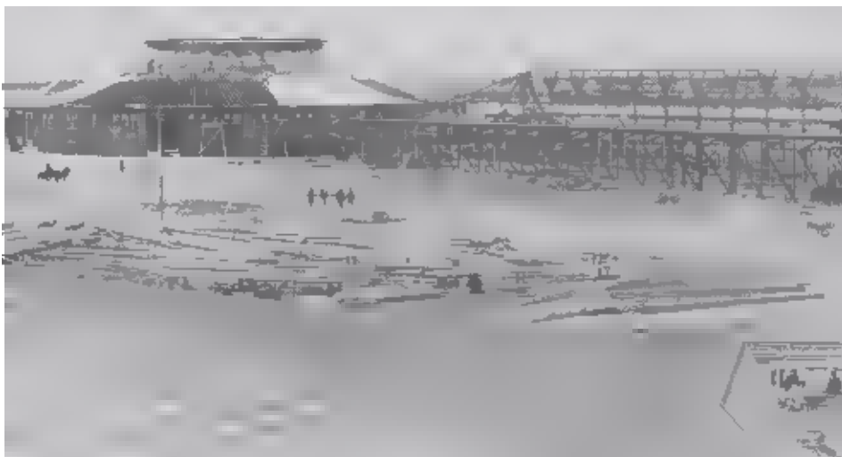
Figura 32. Cubiertas suspendidas para la Exposición Industrial y Artística de toda Rusia, de 1896, en Nizhni Novgorod.
