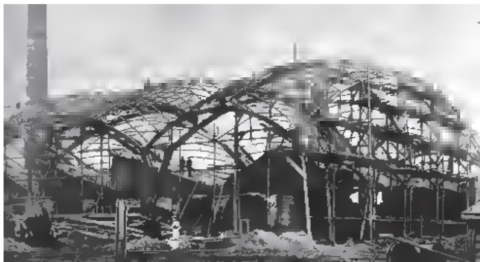
Figura 34. Cubiertas reticuladas comprimidas para la Exposición Industrial y Artística de toda Rusia, de 1896, en Nizhni Novgorod.
