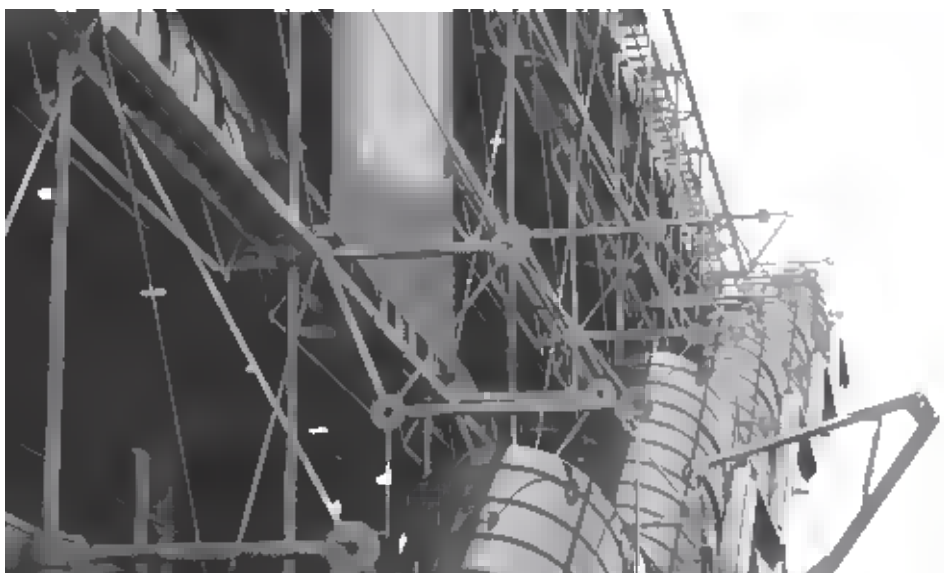
Figura 21. Escalera mecánica suspendida de los extremos de las vigas Gerber del Centro Pompidou, sobre la plaza. Fotografía del autor, 2006.
